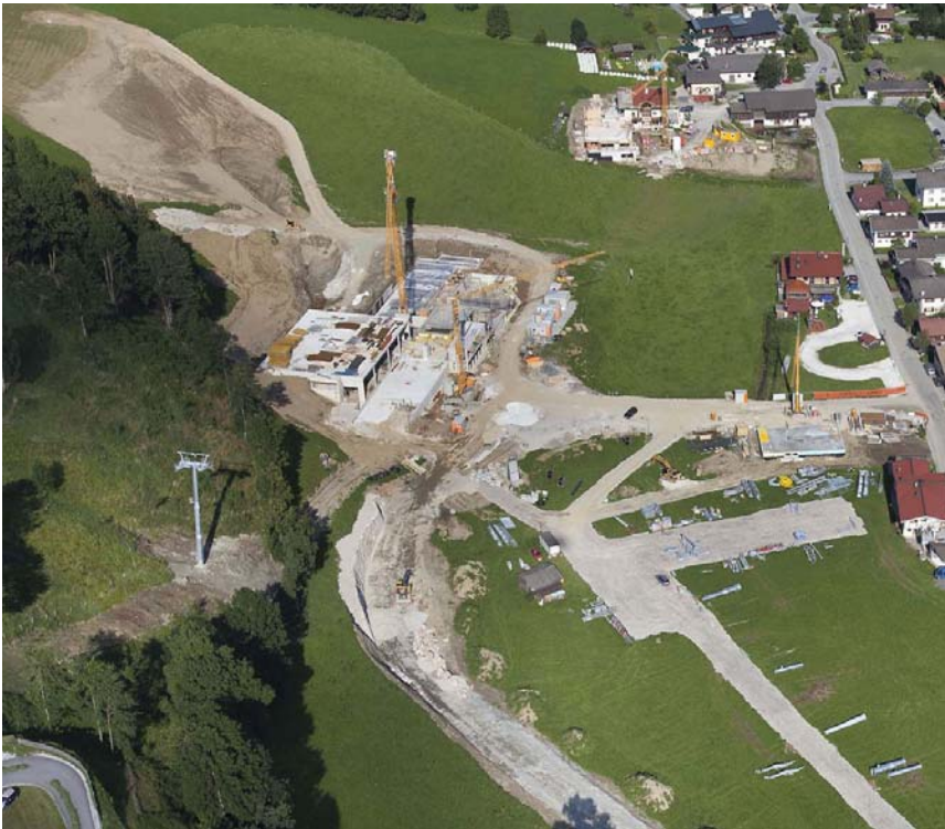
Blick auf den Bau der Talstation der Smaragdbahn 2010 (Bild: Wildkogelbahnen AG).
